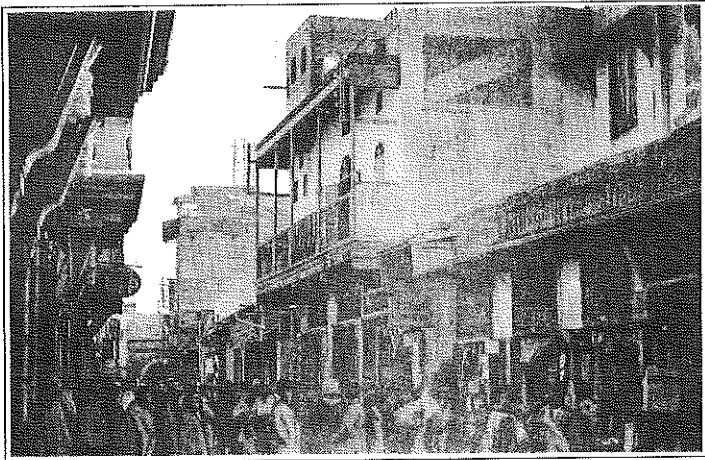
Fès: Grande Rue du Mellah.
